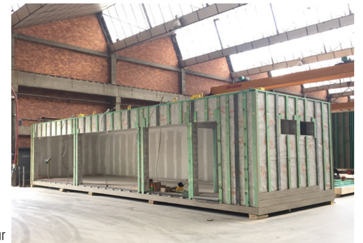
Voorbeeld van een module in opbouw. Ontbreekt de gevelafwerking.
